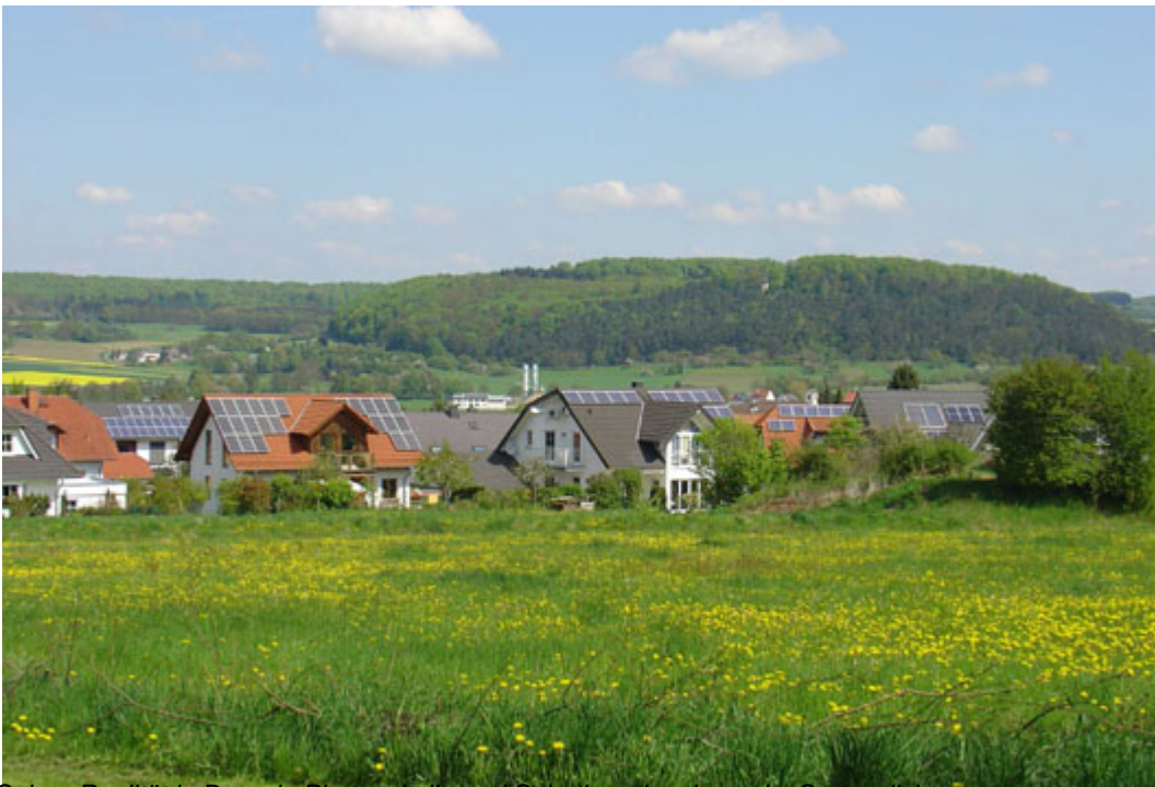
Solare Realität in Buseck: Photovoltaik- und Solarthermieanlagen im Sonnenlicht
